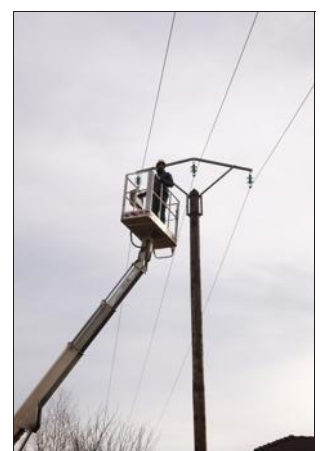
L'utilisation d'une nacelle a été nécessaire. Photo Le DL/J-F.T.
